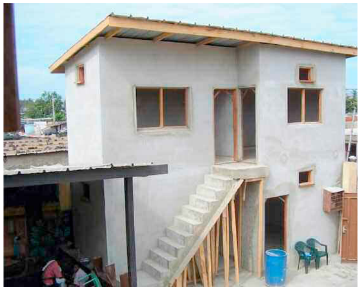
... und nach dem Umbau
