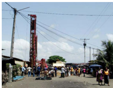
Forage du puits
